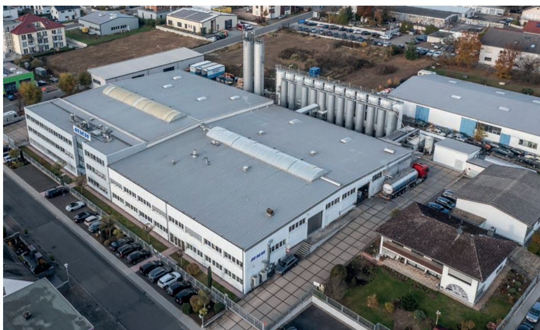
➤ Vue aérienne de l'usine MKU Chimie, implantée à Rödermark
